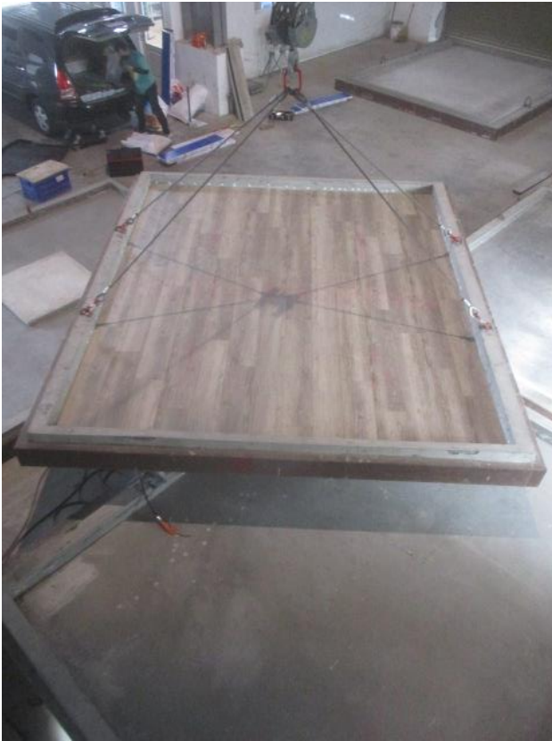
照片 5 試驗件施工完成正面
