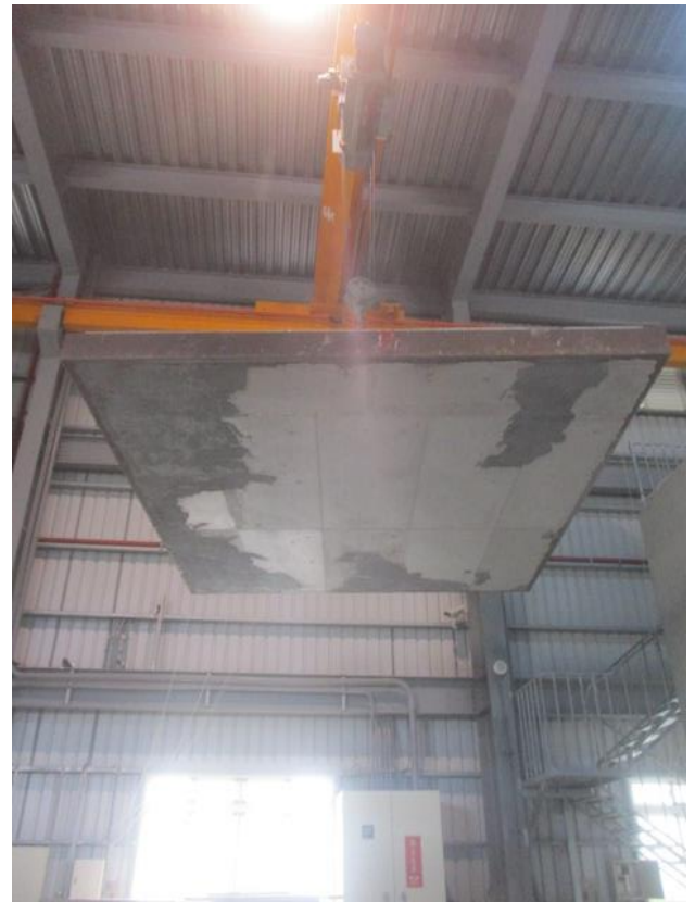
照片 6 試驗件施工完成背面
