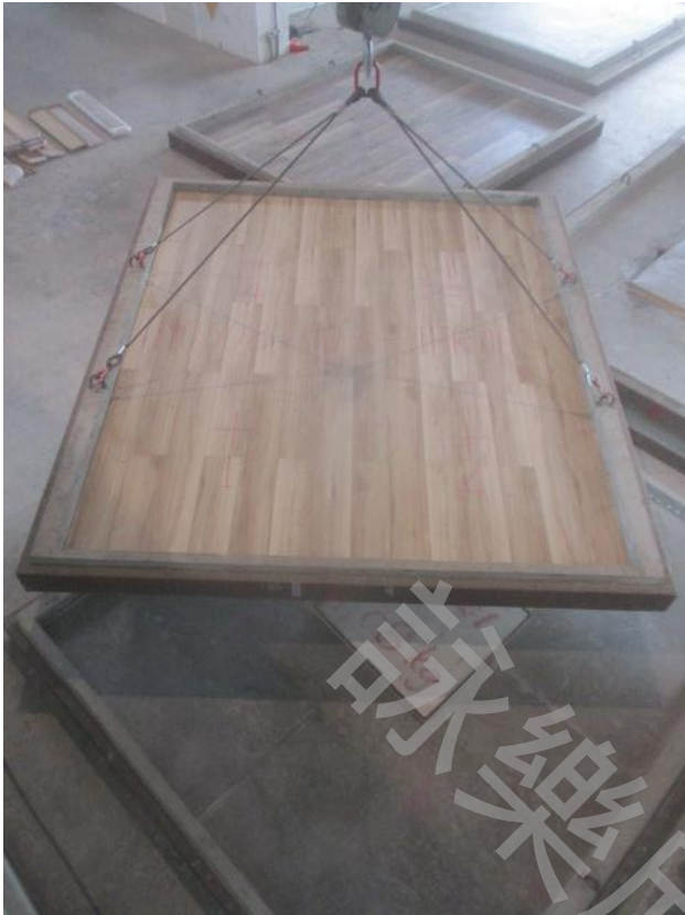
照片 5 試驗件施工完成正面
