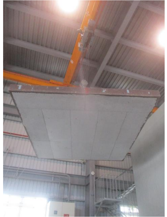
照片 6 試驗件施工完成背面
